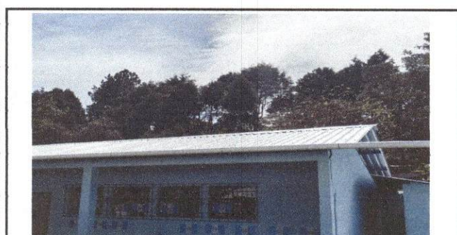
Foto 5. Instalación de lamina troquelada.
