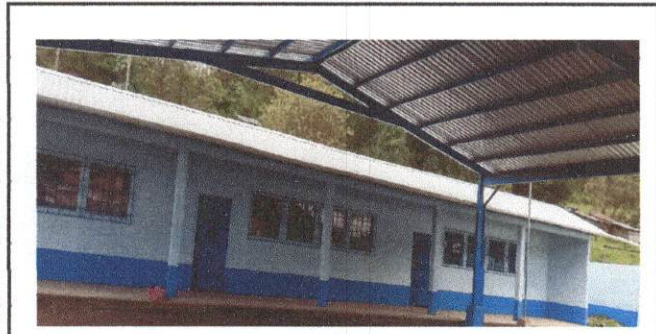
Foto 1. sustitución de lamina por lamina troquelada aluzinc.
