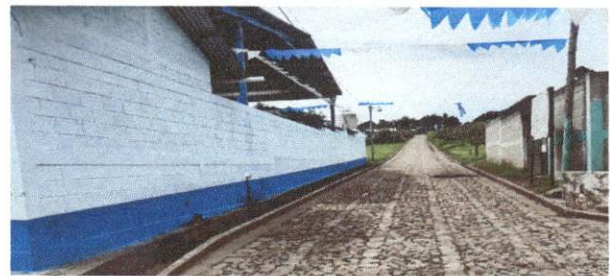
Foto 4. pinturas en muros exteriores.
