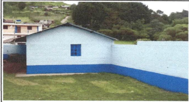
Foto 2. pinturas en muros exteriores.
