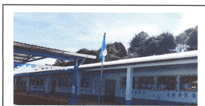
Foto 6. Instalación de bajadas de agua de PVC
