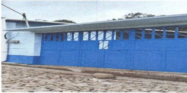
Foto 1. pinturas en muros exteriores.
