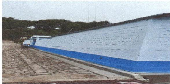
Foto 3. pinturas en muros exteriores.
