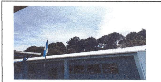
Foto 2 . Canales y bajadas de agua pluvial en modulo de agua.
