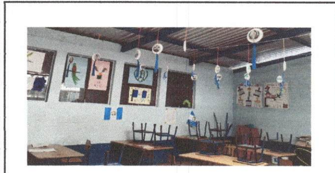
Foto 3. pintura en muros interiores.
