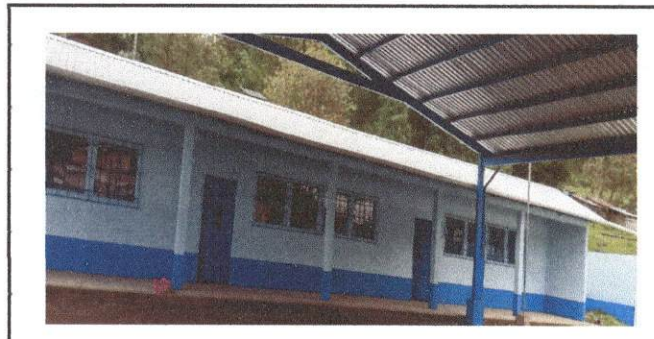
Foto 4. pinturas en muros exteriores.
